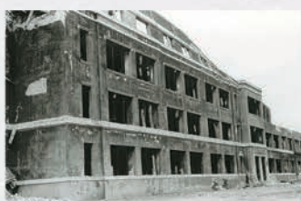
チャペル部分が押しつぶされた1号館
