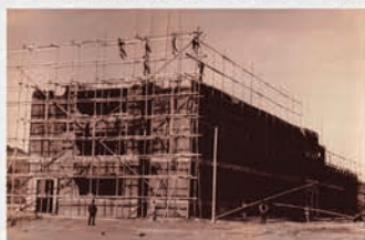
再建途中の1号館
