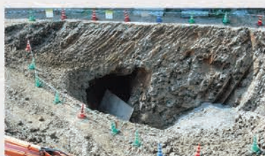
1号館撤去中に出現した地下防空壕
