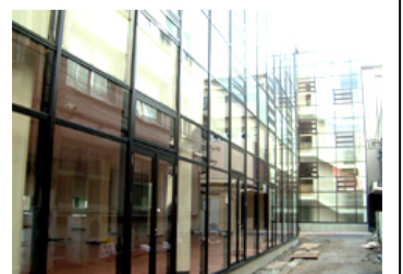
4号館増築部屋内部
