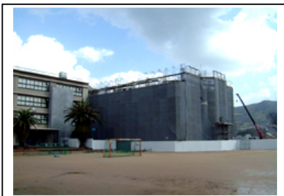
5号館 4階鉄筋工事
