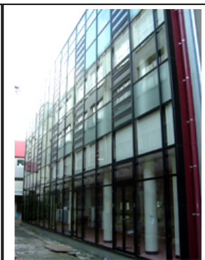
4号館増築工事
