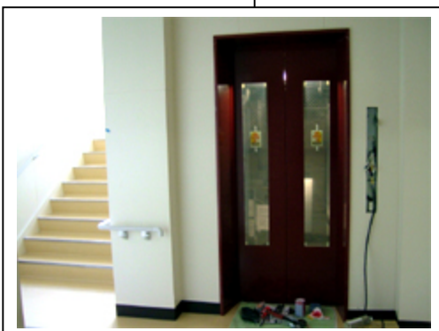
エレベーター工事
